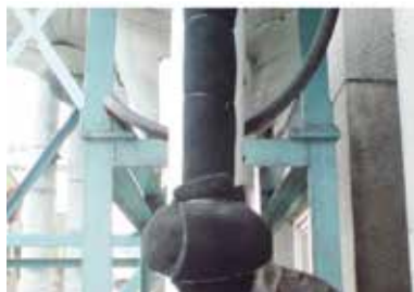
冷凝管 包覆 後
