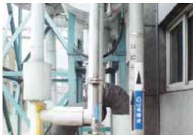
冷凝管 包覆 前
